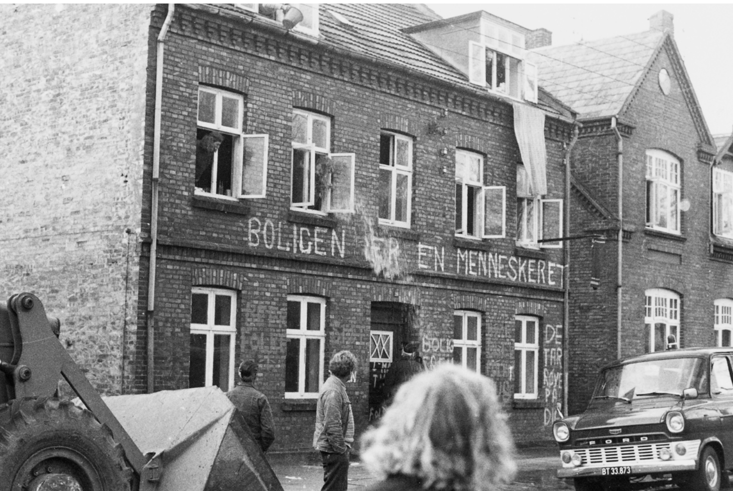
I protest mod planerne om nedrivning af ejendomme til fordel for Centralsygehusets parkeringsplads besatte en gruppe unge mennesker nogle af de nedrivningstruede huse i november 1972. Husene var Rolfsgade 26, 36 og 38 og gav navn til BZerne, der kaldte sig »Rolfsgadegruppen«. Her hilses en besøgende betjent velkommen med en spand vand. (B 50952/Skan: 71857-070)
