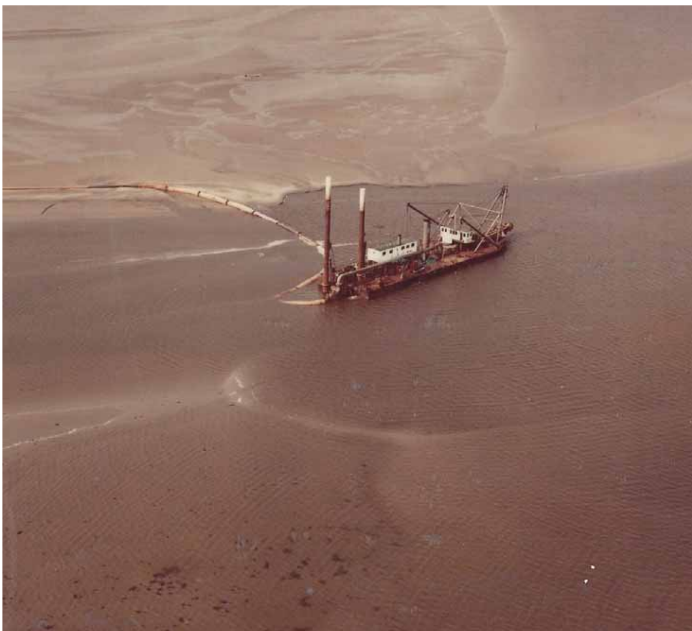
Ved forstærkningen af Ribe Dige 1978-80 blev der brugt en sandpumper til at hente sand ind fra havet. Foto: Farup Sogns Lokalhistoriske Arkiv
