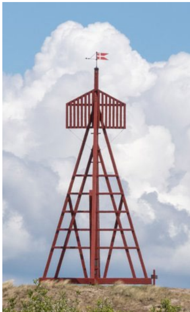
Sømærket Kåveren i Sønderho. Danmarks ældste sømærke fra 1624 som blev genrejst i 2011 på Kåverbjerget, 18,65 meter over havet. Selve Kåveren er 14,50 meter høj, og er blandt andet bygget af 165 år gammelt egetræ fra en holstensk skov ved Lübeck. Foto: Sønderho Sognearkiv
